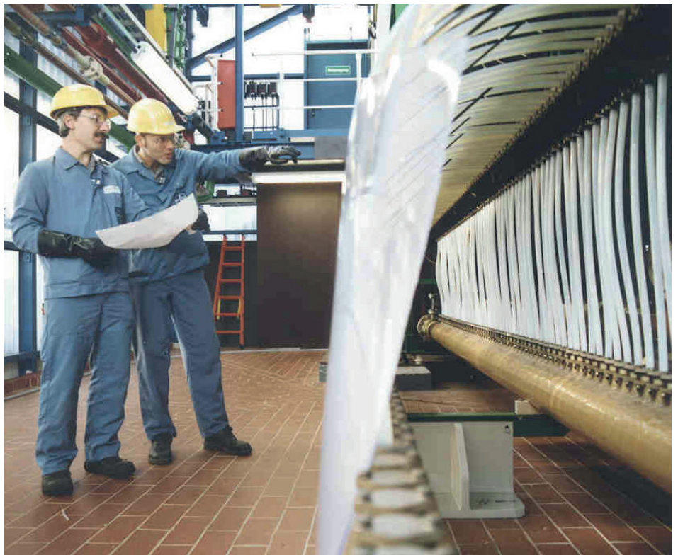
Bei der der neuen Sauerstoffverzehrkathoden (SVK)-Technologie zur Chlorherstellung aus Salzsäure wird Sauerstoff eingespeist. Als Nebenprodukt entsteht Wasser. Jörg Bäther (l.) und Ralf Glashof kontrollieren den Kondensatablauf. Foto: Bayer AG, Bayer Archives Leverkusen
